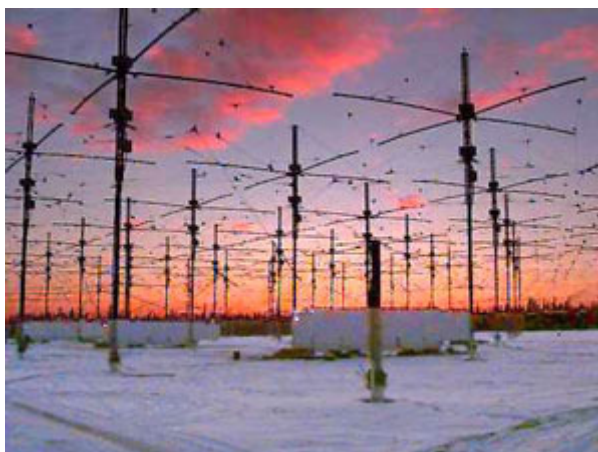
Alcune antenne HAARP in Alaska al tramonto Il tramonto dell'Occidente
